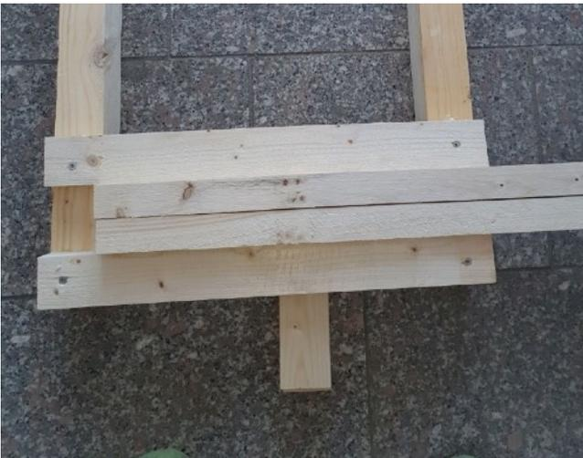
3. Schritt 1 + 2 auf der anderen Seite wiederholen und die Konstruktion auf die andere Seite drehen, sodass die Querleisten nun unten auf dem Boden liegen.
